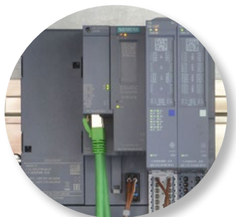
SIEMENS SIMATIC PCS 7
