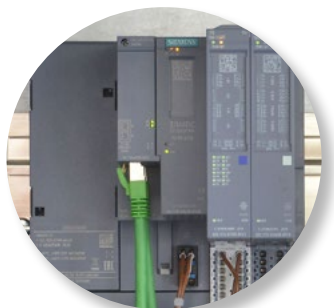
SIEMENS SIMATIC PCS 7
