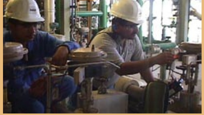
Die Montage und Endkontrolle der Stellventile für den Standort Altamira erfolgt bei der SAMSON-Tochtergesellschaft in Mexiko.
