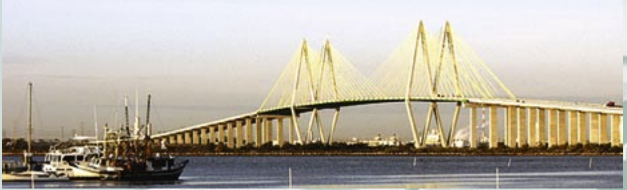
Die Fred Hartman Bridge, die längste und eine der schönsten Brücken von Texas: Die 4.180 Meter lange Schrägseilbrücke aus Stahl überspannt den Houston-Schiffahrtskanal, einen der wichtigsten Verkehrswege der Ölmetropole. Die Pylonen haben eine Höhe von 134 Metern.
