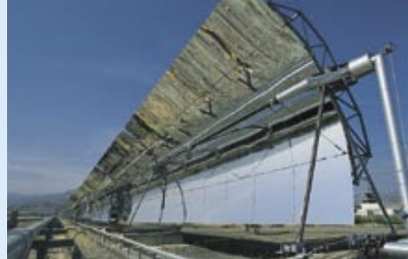
Collecteurs solaires à cuvette parabolique sur la "Plataforma Solar de Almería". Ils concentrent les rayons du soleil directement sur une surface ...
