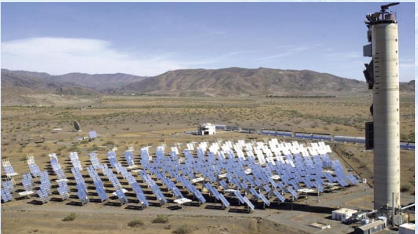
Bis zu 300 Spiegel folgen im spanischen Almería dem Lauf der Sonne und bündeln deren Strahlen auf den Turm CESA I: In dem Solarturmkraftwerk wird aus Sonnenlicht Strom gewonnen.
