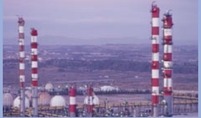
Die Raffinerie von Repsol YPF in Tarragona wird neuesten Umweltstandards gerecht.
