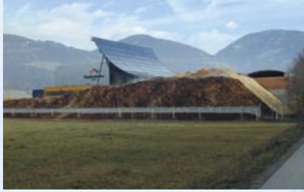
Die Brennstoffqualität von Biomasse unterliegt zwar Schwankungen – ein neues Regelungskonzept jedoch verbesserte den Jahresnutzungsgrad.
