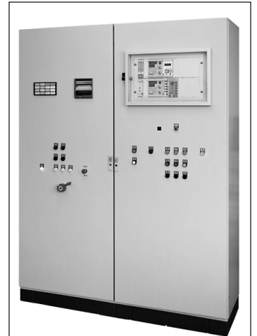
Коммутационный шкаф, содержащий органы управления и технологическое оборудование
